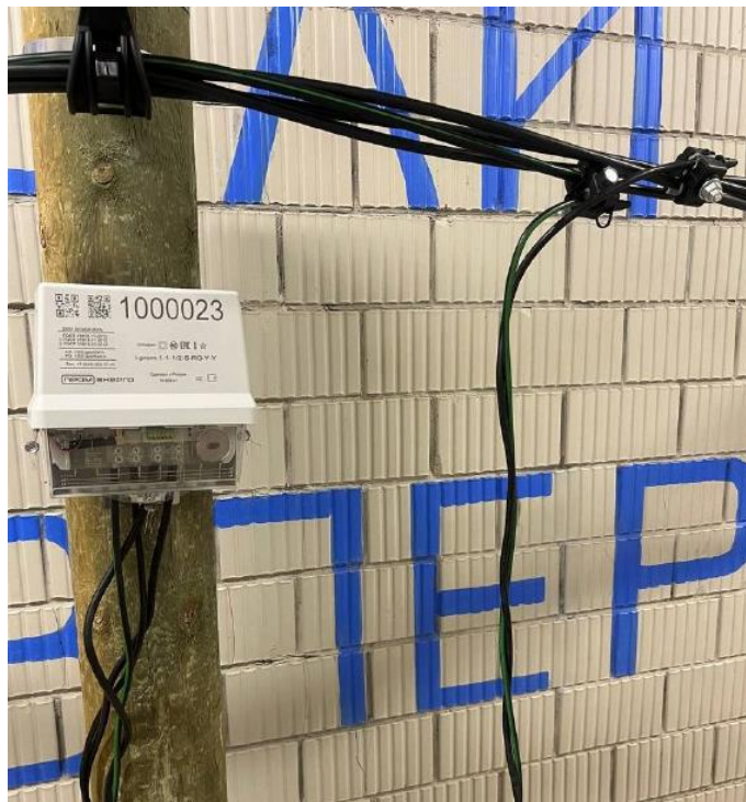
Рисунок 29 – Установка счетчика электрической энергии однофазного многофункционального i-prom.1 в корпусе «S»– на опоре ВЛ-04 кВ
