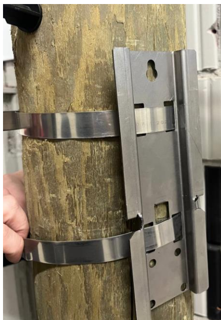
Рисунок 15 – Установка кронштейна на опору для счетчика электрической энергии однофазного многофункционального i-prom.1 в корпусе «S»– на опору
