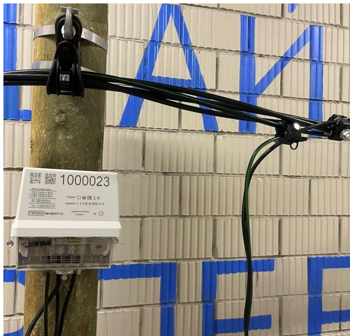
Рисунок 25 – Подключения счетчика электрической энергии однофазного многофункционального i-grom.1 в корпусе «S»– на опоре
